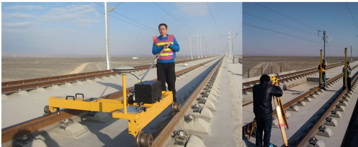
图 5-11 A-INS 轨检小车及水准测量作业图；水准尺放置在每根轨枕对应的钢轨轨顶面处测量对应的左右钢轨的轨面高程
